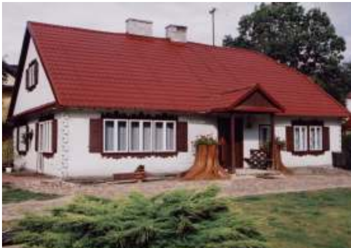
Budynek typu dworkowego ul. Międzyrzecka 48
